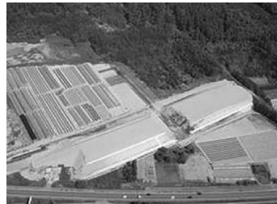
日本海沿岸東北自動車道工事進捗状況
