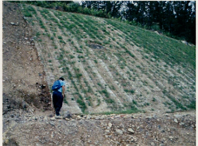
②緑化施工状況の確認
