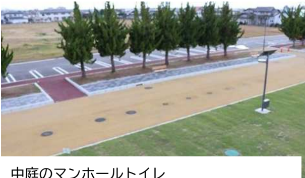
中庭のマンホールトイレ
