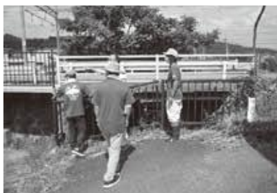
排水ポンプ設置場所
