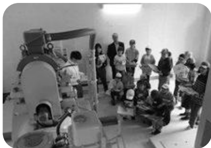
平津小水力発電所で学ぶ (令和2年・高瀬小)
