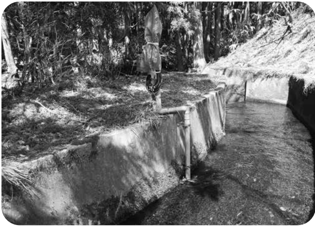
横堰の水位観測（臂曲地内）
