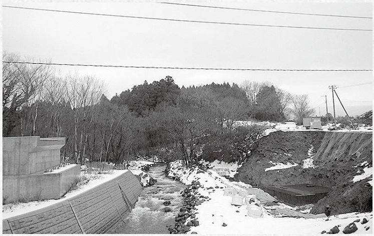
下流から見た工事現場 右手が現在工事中
