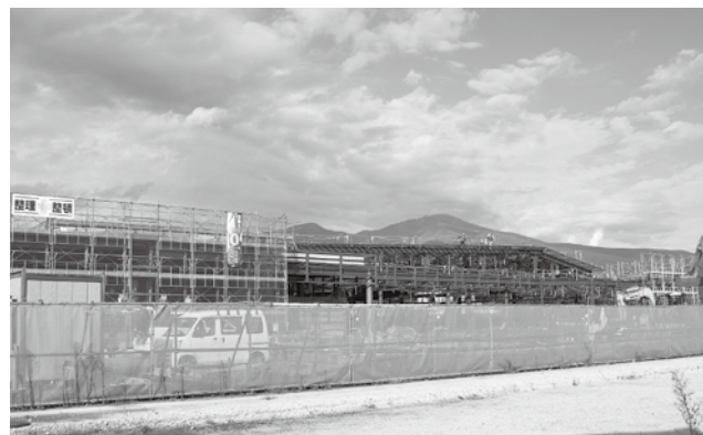
建設中の新庁舎
