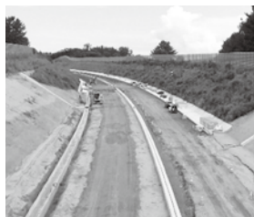
工事が進む 遊佐町茂り松付近
