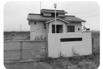
町内の下水処理施設
