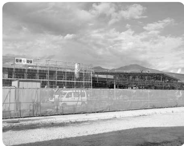
工事が進む新庁舎
