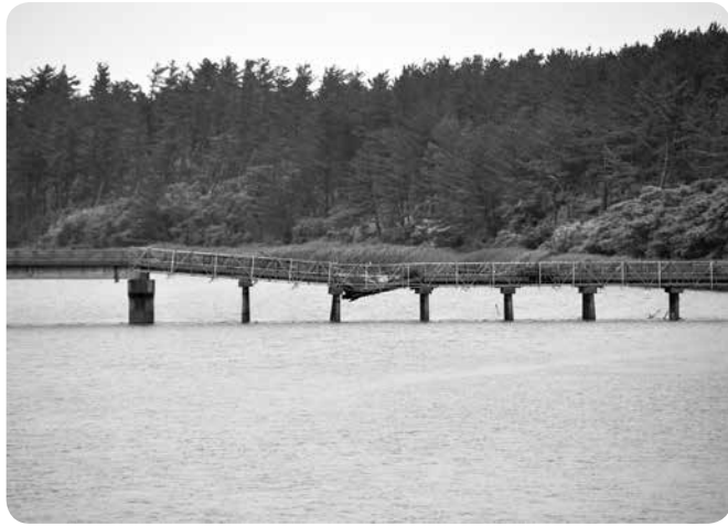
崩落して危険な栄橋（日向川河口付近）
