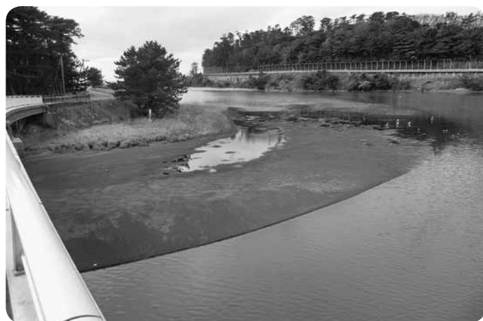
西浜橋下流の堆積土砂
