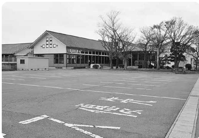
増設工事予定地（遊佐小学校）
