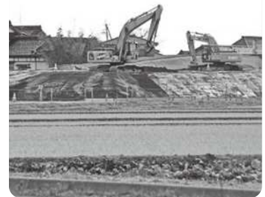
日浴道 丸子地内も工事進む
