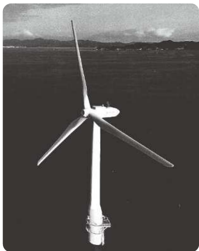
五島市における浮体式洋上風力発電
