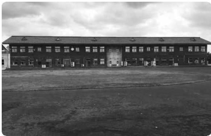
高瀬小学校校舎 平成17年竣工
