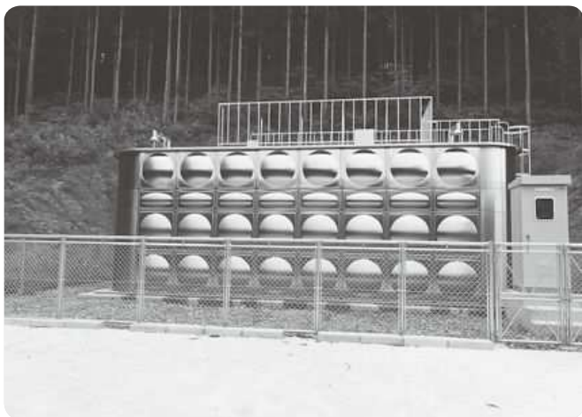
上寺配水池（30年度完成）
