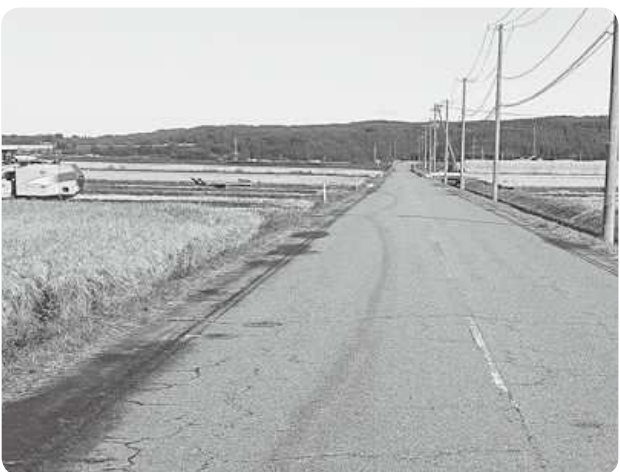
丸池様へのバスの通行が多い町道
