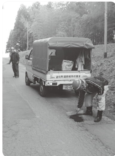
町道維持作業
