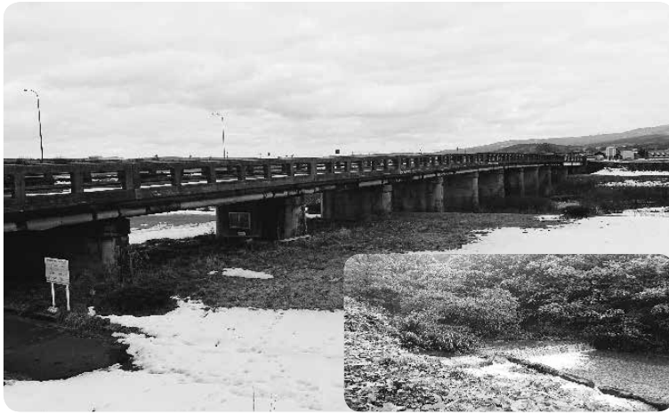
旧朝日橋と洗沢川上流部 (30年8月撮影)
