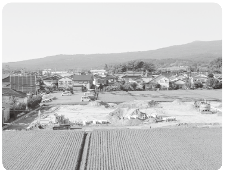
若者向け住宅地造成
