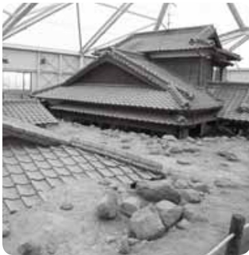
屋根まで土石流に埋もれた家屋 (土石流被災家屋保存公園)
