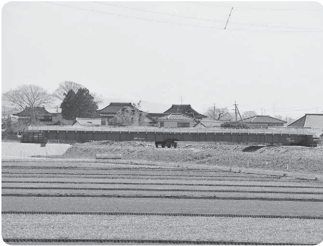
丸子地内の仮設橋
