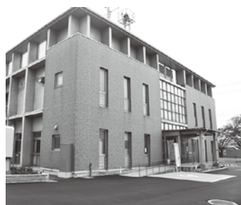
防災センター
