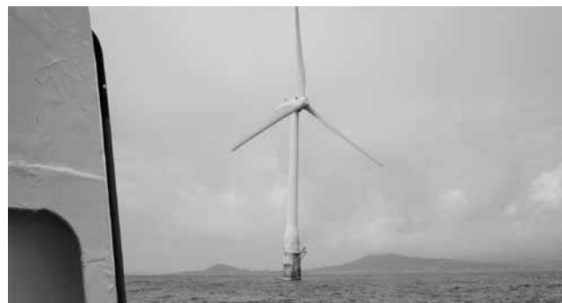
長崎五島の浮体式洋上風車
